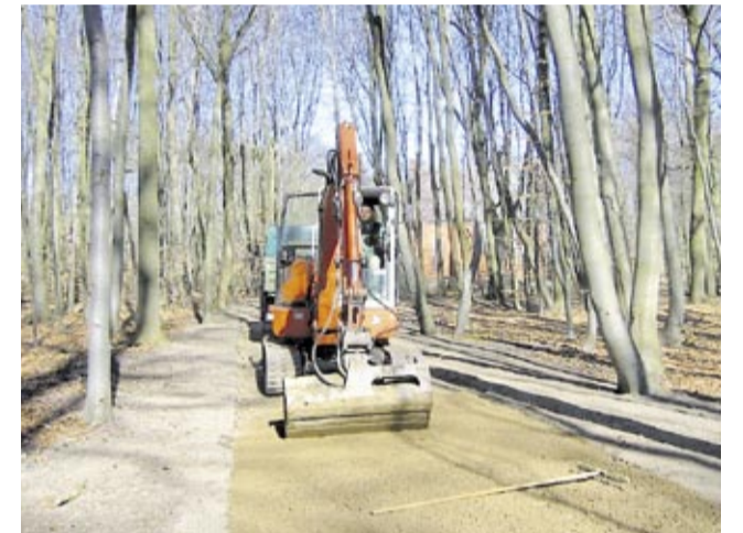
Schweres Gerät: Inzwischen sind die Arbeiter abgezogen.
